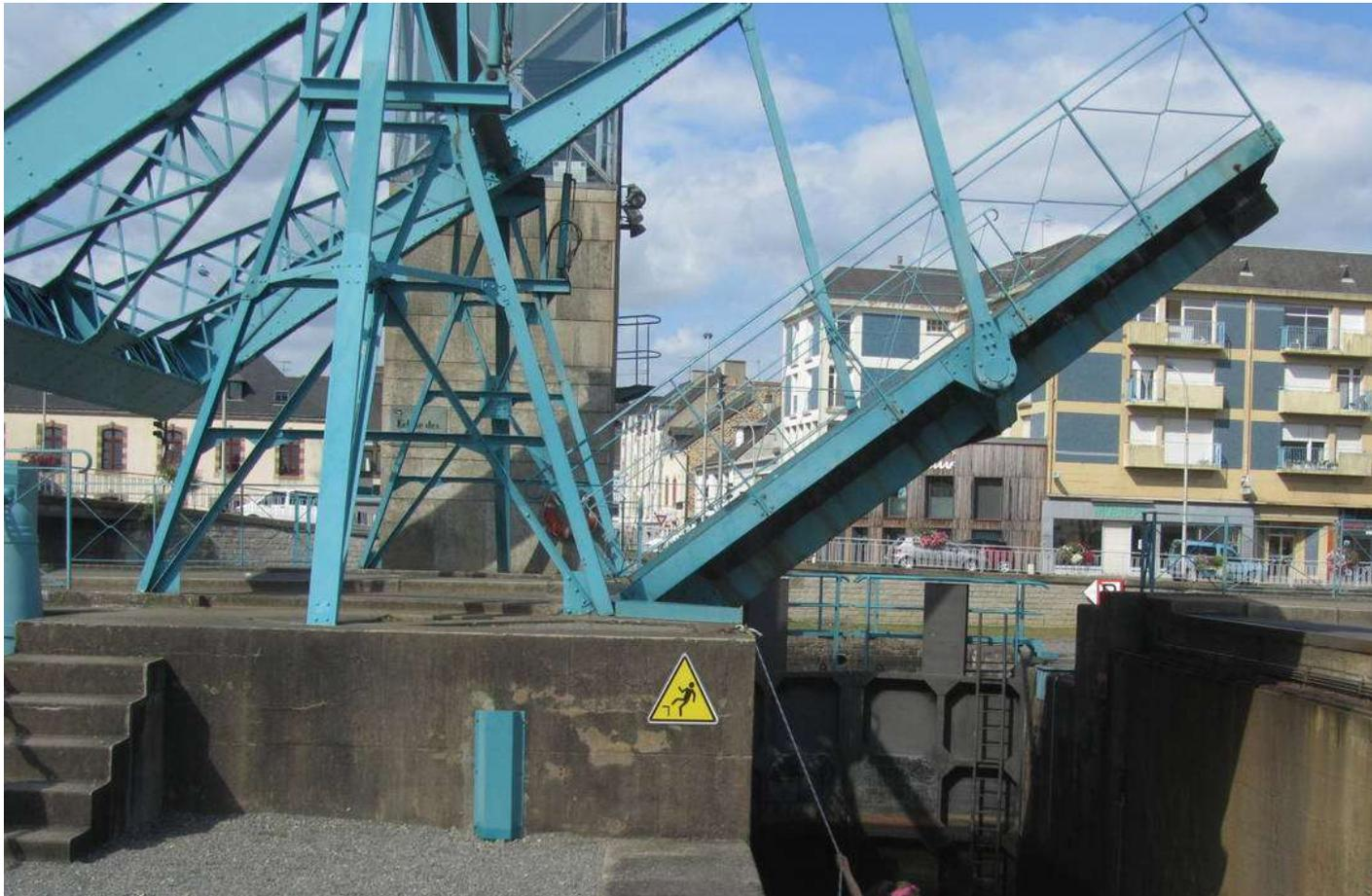
Le pont basculant actuel, au-dessus de l'écluse d'isolement ou écluse des bateliers. | OUEST-FRANCE
